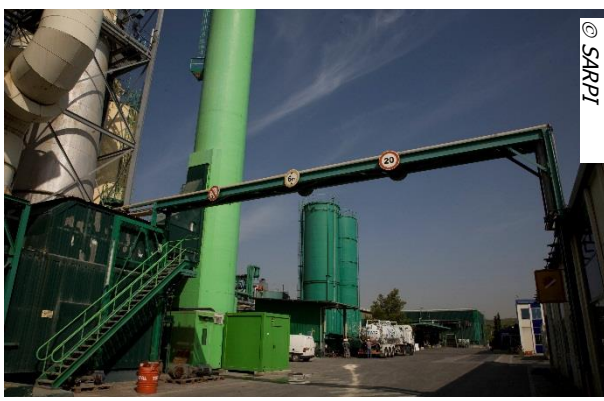
Plateforme de regroupement des produits dangereux avant acheminement vers le centre de traitement – SARPI La Talaudière
